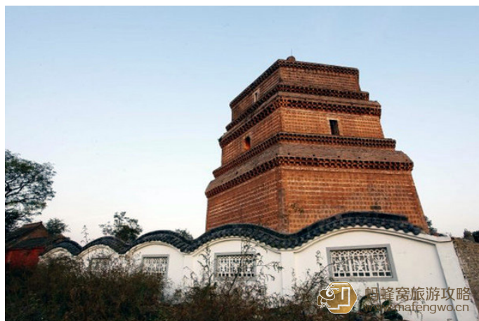
喜滢滢 繁塔——开封地区现存最古老的建筑。
